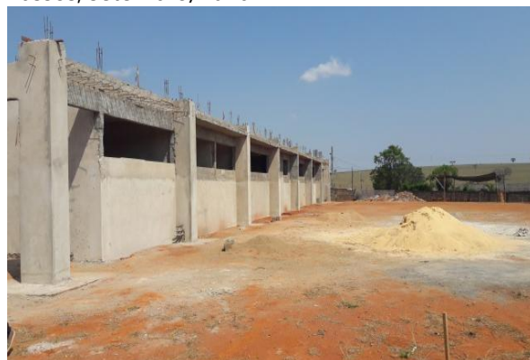
Figura 18: Relatório fotográfico - Cento de Iniciação ao Esporte (CIE), construção do CIE Passos, setembro/2016
